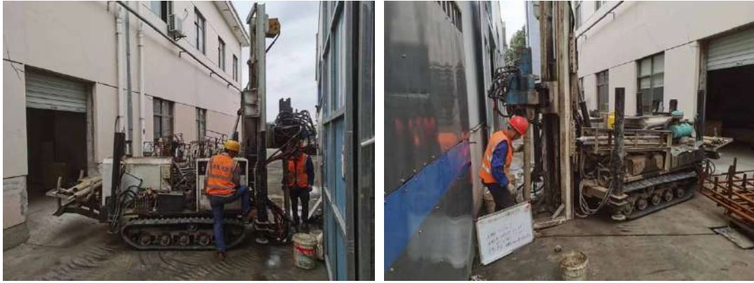
图 6.3-1 采样钻探作业图
