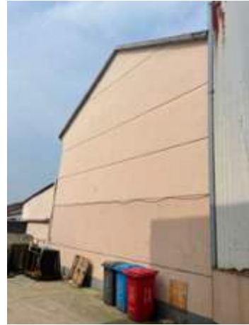
国力特租用厂房（原生产车间1、仓库1）
