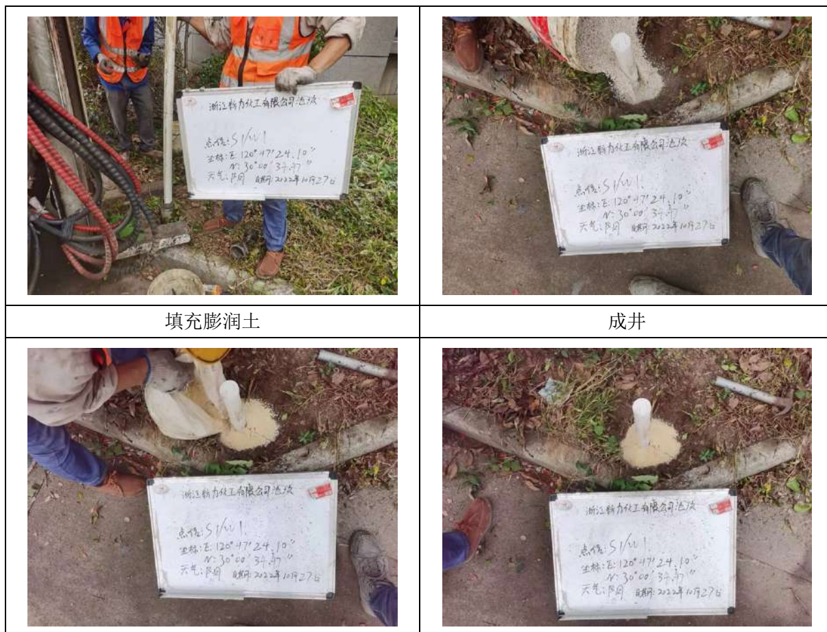
图 6.3-6 采样下管作业
