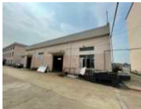
原污水站、危废库（闲置）
